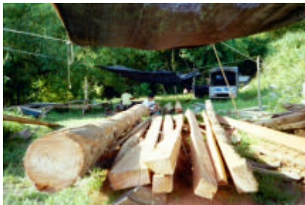
( 15 ) 2003 年九月中旬，從立德海邊吊回這根長 12 公尺的南洋櫟木，重建古房舍的主橫樑與主立柱，有了著落。收集材料的同時，工作人員就現有的材料進行橫樑與立柱的組裝。
