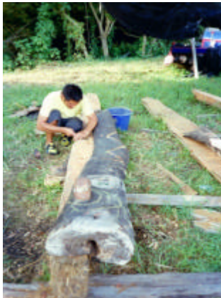
( 16 ) 主立柱之一。主立柱共有三根，高四公尺。每一根造型各異，由部落青年發揮創意進行雕刻，結構要學習古法，堅固穩當經得起颱風與地震。
