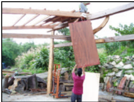
古時的屋頂用桂竹或茅竿編成，上面鋪厚茅草。我們則用厚木板先鋪一層，木板的下面再鋪竹編，木板的上面先鋪一層防水材後，再鋪上厚茅草。
