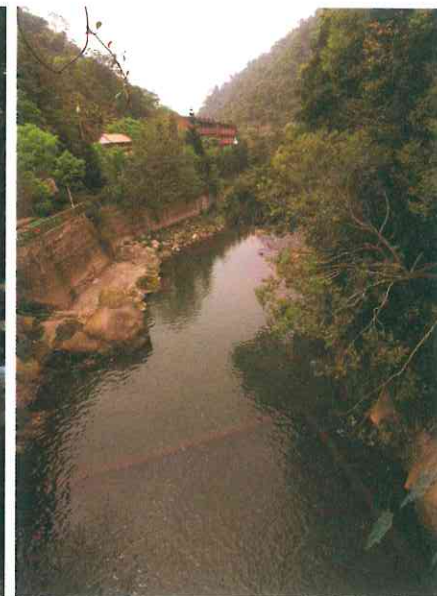
▲錦山溪水系上游—錦山橋
