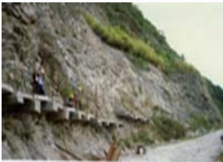
圖 2-5. 懸臂樑植生槽工法施工情形
