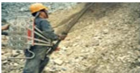
圖 2-13 噴漿工法施工情形
