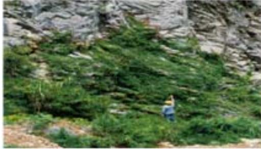
圖 2-3. 邊坡壁腳腹地植生工法爬牆虎生長迅速
