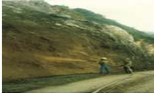
圖 2-7. 噴漿工法施工情形
