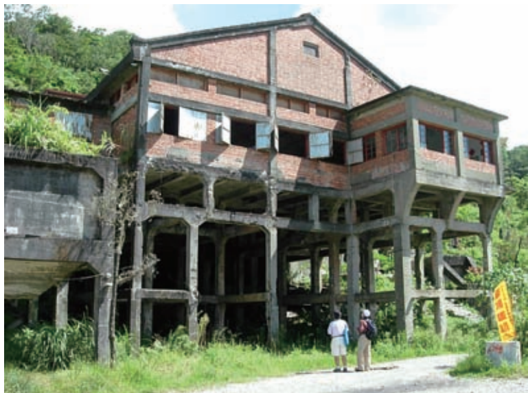
在菁桐車站附近的石底煤礦廢棄卸煤場
