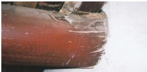
←樑桁在牆內的部份已完全蛀空
