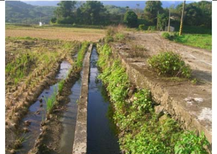
16 圳路 0k+305 混凝土內面工
