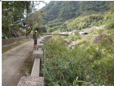
07 圳路 0k330 塑膠管管路
