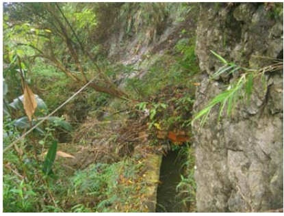
32 圳路 0k+422 混凝土暗渠
