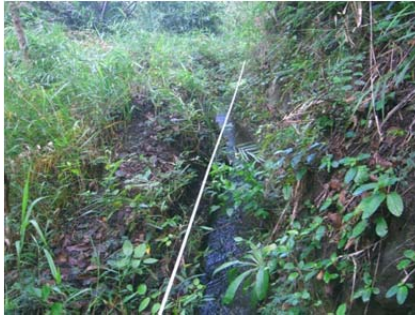
35 圳路 0k+490 混凝土內面工
