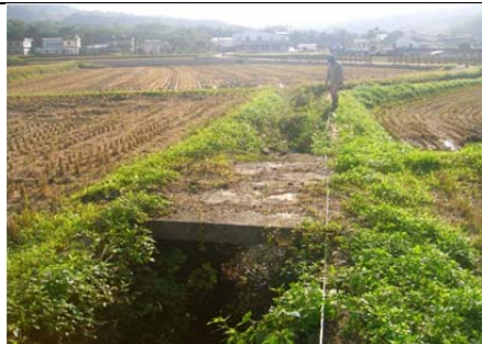
11 圳路 0k+375.5 混凝土農路橋
