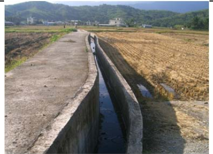
12 圳路 0k+135 凝土內面工
