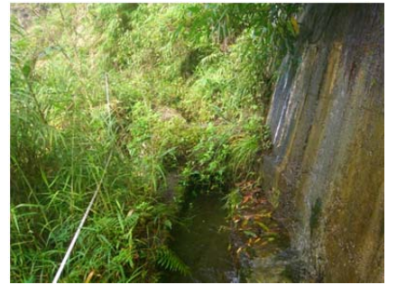
40 圳路 0k+558 混凝土內面工 公路護牆
