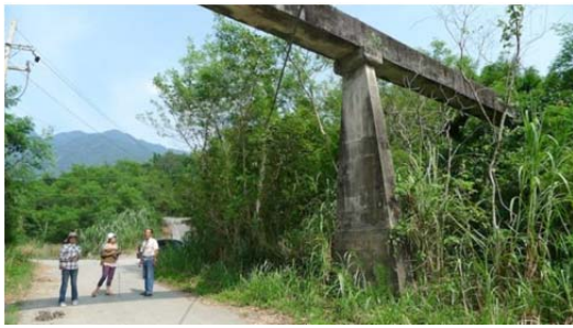
11 跨越永豐村復興產業道路的鋼筋混凝土渡槽
