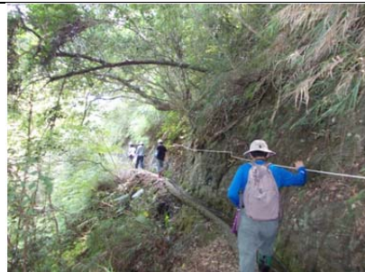
16 圳路 0k500 混凝土雙面工 及人行扶繩
