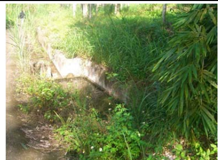
60 圳路 0k+910 混凝土沉沙池
