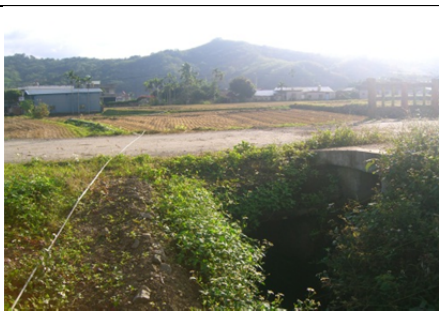
13 圳路 0k+431 混凝土農路暗渠
