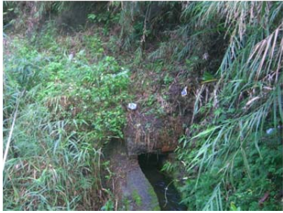
20 圳路 0k+241 混凝土暗渠
