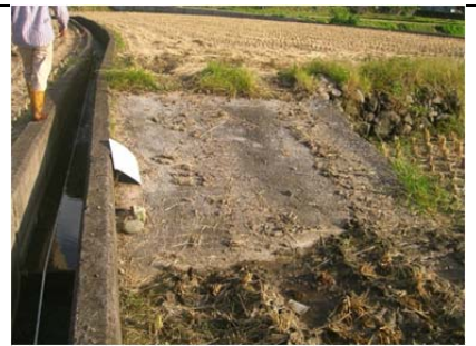
09 圳路 0k+190 混凝土內面工
