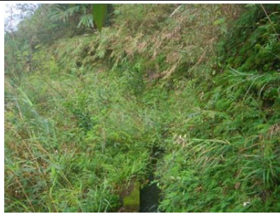
18 圳路 0k+180 混凝土內面工
