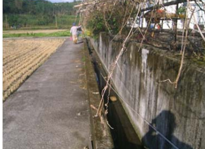
23 圳路 0k+421 混凝土內面工
