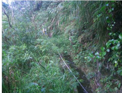
21 圳路 0k+260 混凝土內面工
