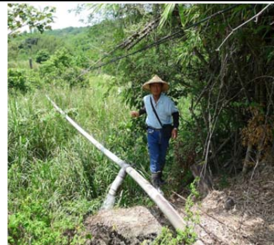
16 豐南村臭水溝一帶之塑膠管吊橋
