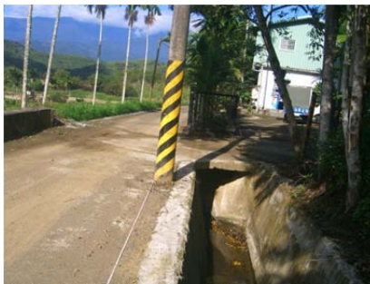
52 圳路 0k+760 混凝土農路暗渠
