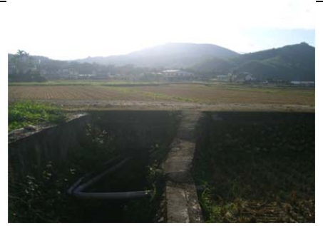
06 圳路 0k+252 混凝土農路橋
