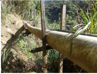
17 圳路 0k638 塑膠管渡槽
