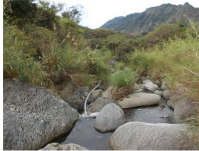
01 永豐圳 10 分 4 給進水口
