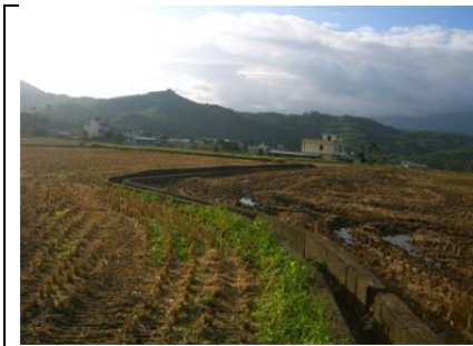
07 圳路 0k+140 混凝土內面工
