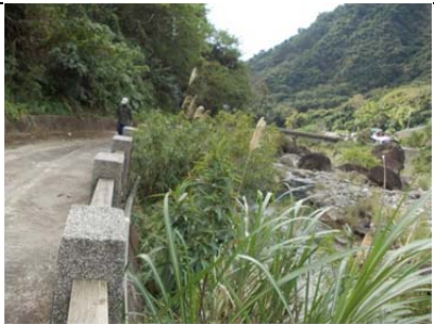
06 圳路 0k230 塑膠管管路
