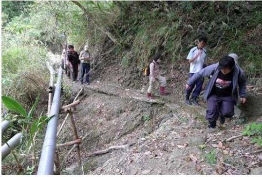
13 第一號 (Urayama) 水圳之塑膠管渡槽
