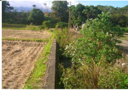
08 圳路 0k+270 混凝土砌塊石內面工
