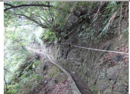
16 圳路 0k500 混凝土雙面工 及人行扶繩
