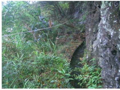
33 圳路 0k+440 混凝土內面工
