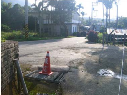
07 圳路 0k+081 凝土暗渠工
