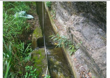
43 圳路 0k+604 混凝土排水孔
