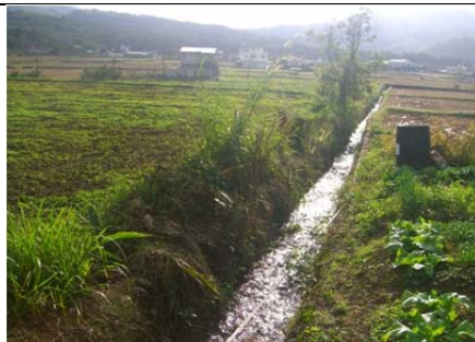
02 圳路 0k+140 混凝土砌塊石內面工
