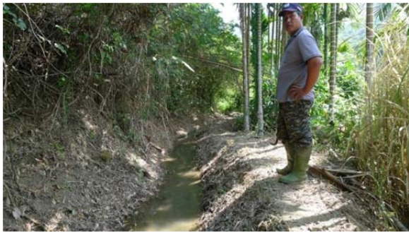
01 第二號 (Cikimay) 水圳之普通土渠
