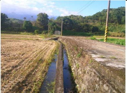
16 圳路 0k+305 混凝土內面工
