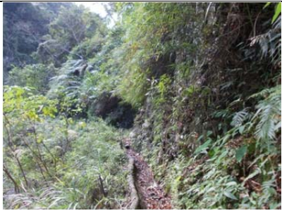
03 圳路 0k095 塑膠管管路
