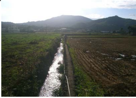
04 圳路 0k+210 混凝土砌塊石內面工
