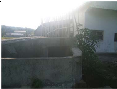
20 圳路 0k+369 混凝土暗渠工
