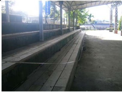
05 圳路 0k+048 凝土暗渠工
