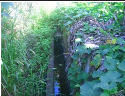
58 圳路 0k+872 混凝土內面工
