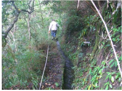
36 圳路 0k+500 混凝土
