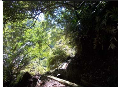
10 圳路 0k417 塑膠管渡槽
