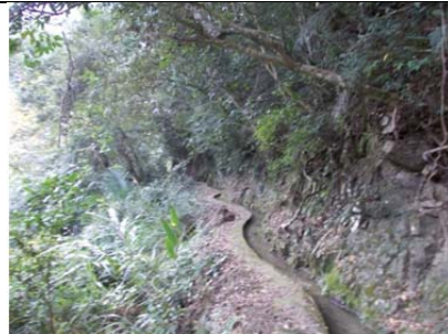
13 圳路 0k300 混凝土雙面工
