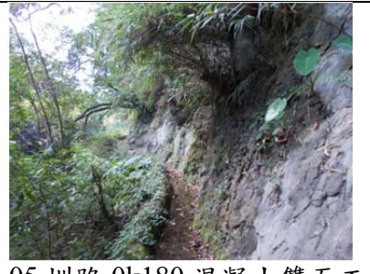
05 圳路 0k180 混凝土雙面工
