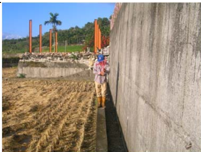
02 圳路 0k+002 混凝土內面工
