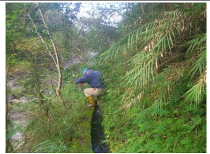
19 圳路 0k+200 混凝土內面工
