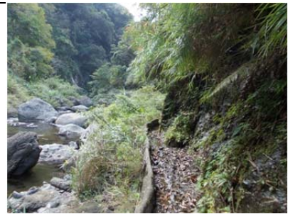
02 圳路 0k060 混凝土雙面工
