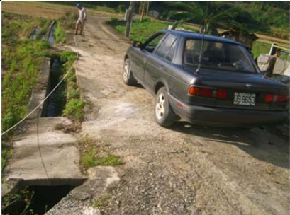
13 圳路 0k+296 凝土人行橋
