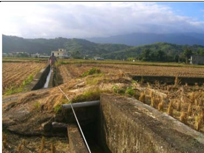
05 圳路 0k+078 混凝土農路橋
