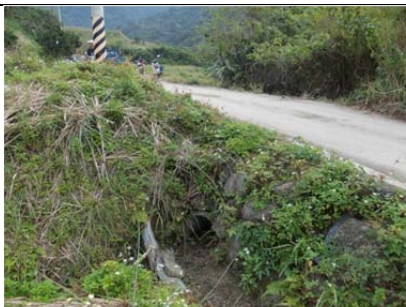
23 圳路 0k811 混凝土農路暗渠
