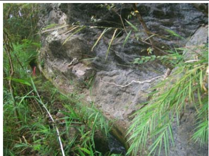
44 圳路 0k+610 混凝土內面工
