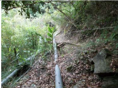
08 圳路 0k137 渡槽 02
