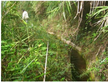
38 圳路 0k+570 混凝土內面工
