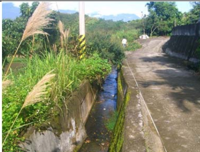
55 圳路 0k+816 混凝土內面工
