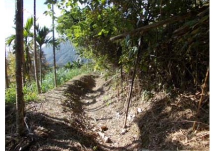
16 圳路 0k615 土渠
