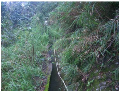
23 圳路 0k+300 混凝土內面工
