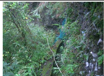
31 圳路 0k+409 混凝土內面工
