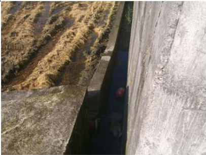
10 圳路 0k+107 凝土分水口
