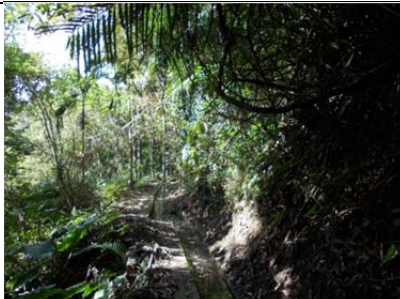
08 圳路 0k300 混凝土內面工
