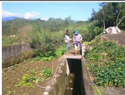
56 圳路 0k+850 混凝土暗渠
