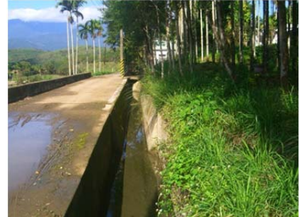
51 圳路 0k+729 混凝土內面工
