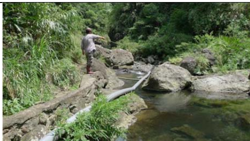
09 第二號 (Cikimay) 水圳之混凝土砌塊石內面工及取水口原址
