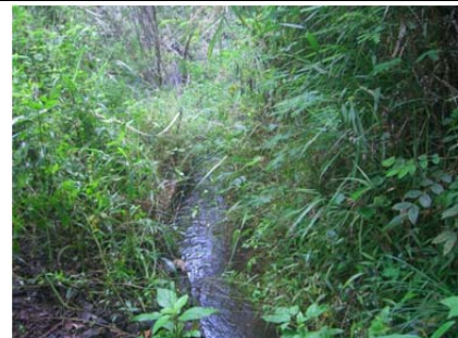
25 圳路 0k+352 混凝土內面工
