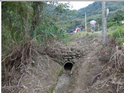
21 圳路 0k780 混凝土土管暗渠
