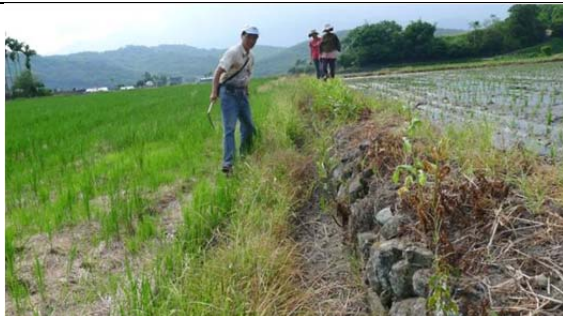
05 豐南村活動中心旁之乾砌塊石內面工
