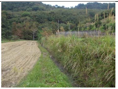
24 圳路 0k820 土渠
