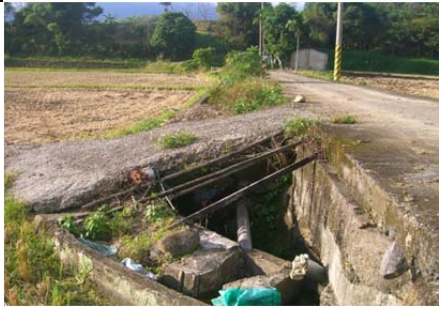
07 圳路 0k+260 混凝土農路橋
