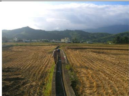
04 圳路 0k+050 混凝土內面工
