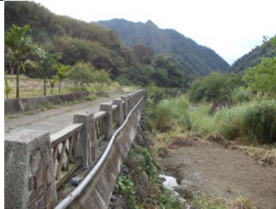
04 圳路 0k263 塑膠管管路
