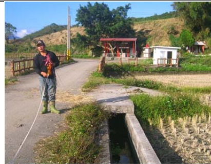
27 圳路 0k+601 混凝土農路橋
