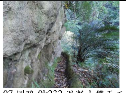
07 圳路 0k232 混凝土雙面工
