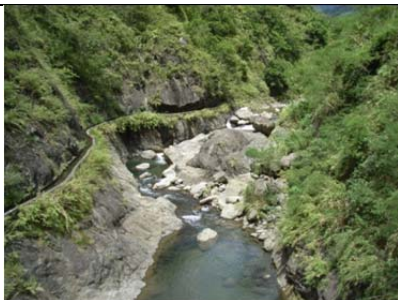
07 石門圳之斷層切割工法與外側之混凝土砌塊石內面工
