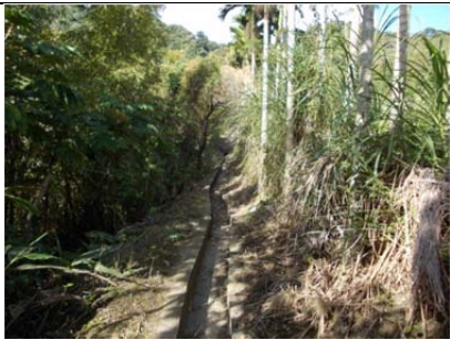
20 圳路 0k690 混凝土內面工
