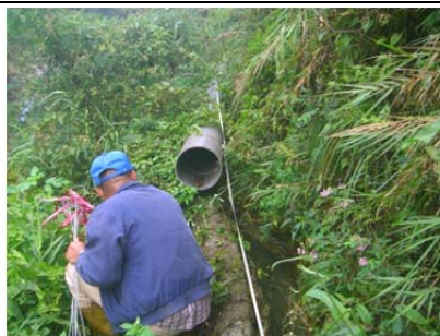
30 圳路 0k+401 塑膠管渡槽
