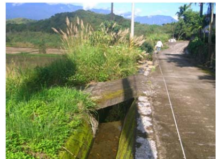
54 圳路 0k+811 混凝土農路橋
