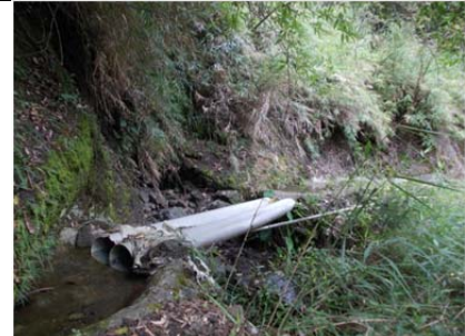
09 圳路 0k163 渡槽
