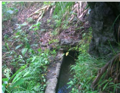
24 圳路 0k+344 混凝土暗渠
