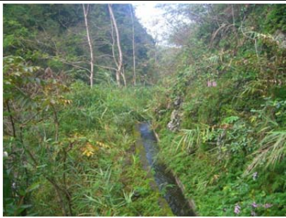
17 圳路 0k+160 混凝土內面工
