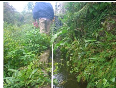
29 圳路 0k+397 混凝土內面工
