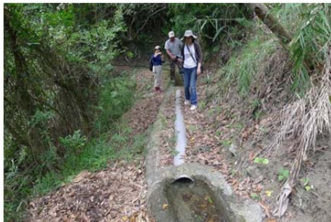
17 豐南村第一號 (Urayama) 水圳之塑膠管暗渠
