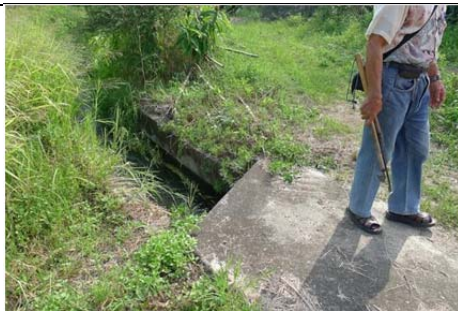
19 豐南村頂埔圳之農機橋橋板
