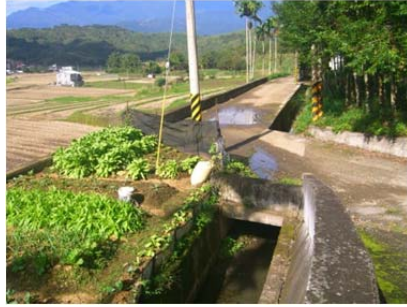
50 圳路 0k+719 混凝土農路橋
