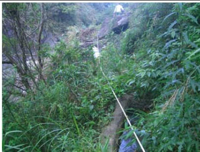
26 圳路 0k+356 塑膠管渡槽
