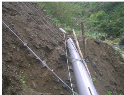
27 圳路 0k+370 塑膠管渡槽鋼索懸吊
