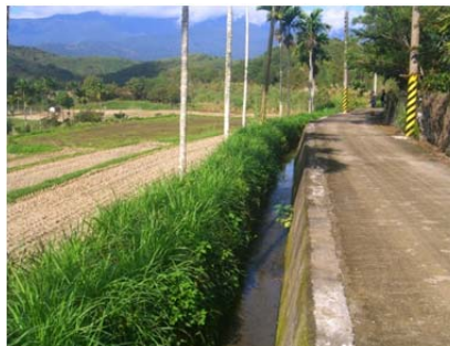
53 圳路 0k+767 混凝土內面工
