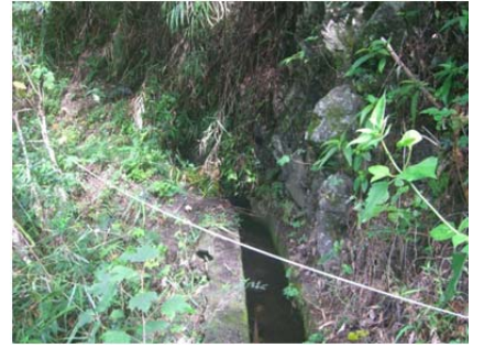
37 圳路 0k+530 混凝土內面工
