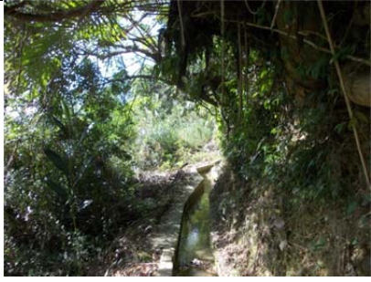
11 圳路 0k450 混凝土內面工
