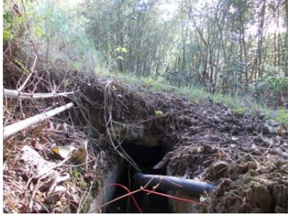
14 圳路 0k535 混凝土農路暗渠
