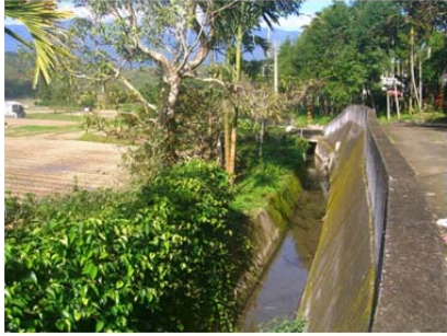
49 圳路 0k+674 混凝土內外面工
