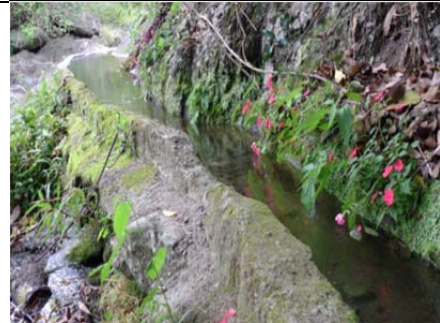
04 第四號水圳之混凝土內面工
