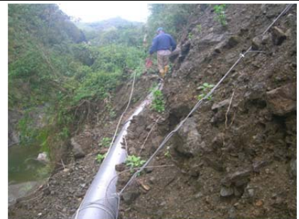
28 圳路 0k+380 塑膠管渡槽鋼索懸吊
