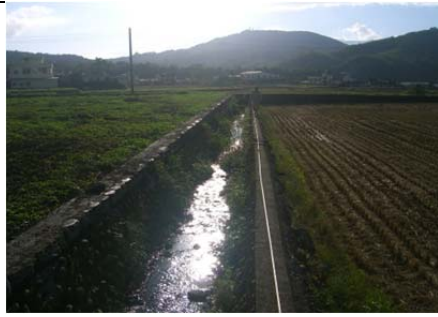
05 圳路 0k+230 混凝土砌塊石內面工
