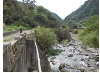
05 圳路 0k210 塑膠管管路
