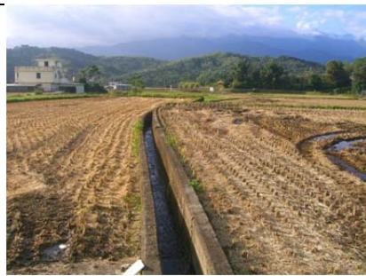
08 圳路 0k+180 混凝土內面工
