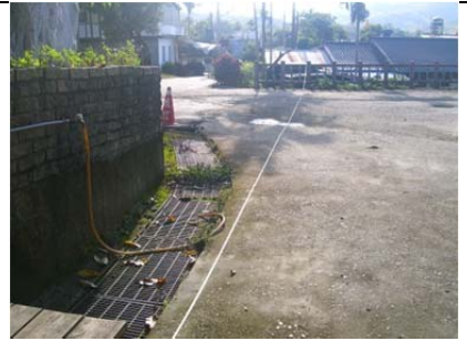
06 圳路 0k+074 凝土暗渠工
