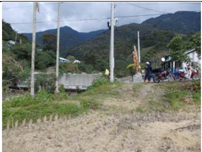
09 圳路 0k390 塑膠管管路出口
