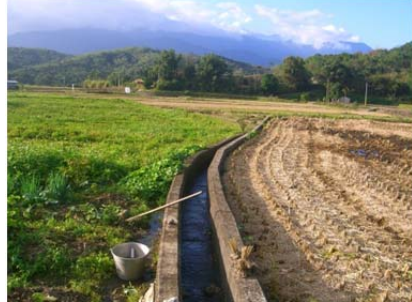
11 圳路 0k+240 混凝土內面工
