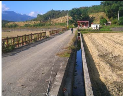
26 圳路 0k+565 混凝土內面工
