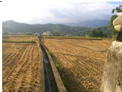
03 圳路 0k+030 混凝土內面工
