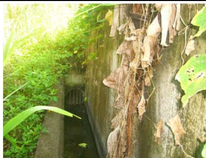
59 圳路 0k+878 土管暗渠
