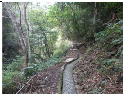
06 圳路 0k080 混凝土內面工
