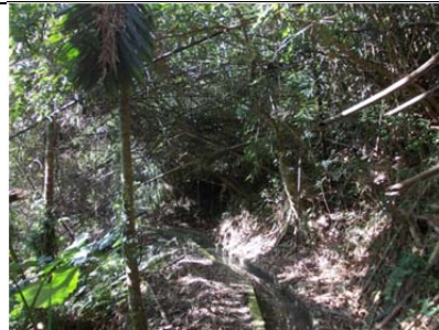
09 圳路 0k380 混凝土內面工
