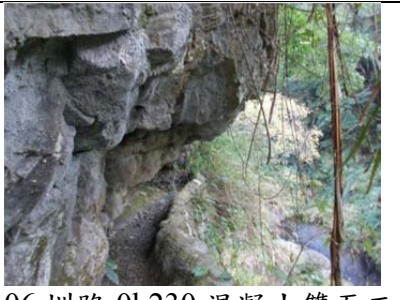
06 圳路 0k230 混凝土雙面工
