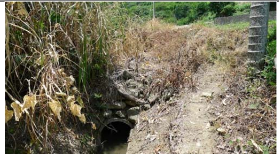
18 豐南村第二號 (Cikimay) 水圳圳尾附近之混凝土管暗渠
