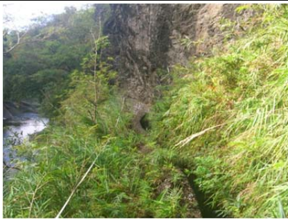
41 圳路 0k+573 混凝土內面
