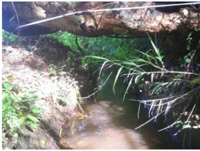
46 圳路 0k+615 混凝土內面工
