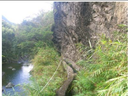
42 圳路 0k+580 混凝土內面工
