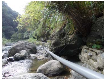
01 圳路 0k030 進水口塑膠管
