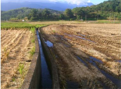
10 圳路 0k+210 混凝土內面工
