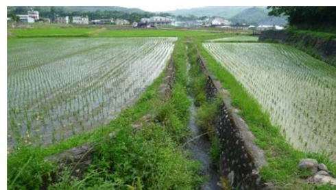
10 豐南村活動中心旁之混凝土砌塊石內面工
