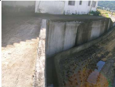
11 圳路 0k+110 凝土內面工
