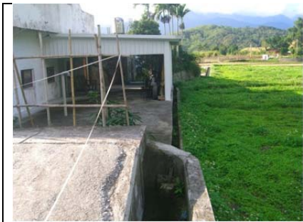
19 圳路 0k+369 混凝土暗渠工
