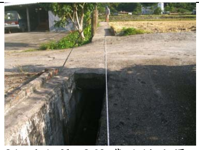
21 圳路 0k+369 農路橋暗渠工
