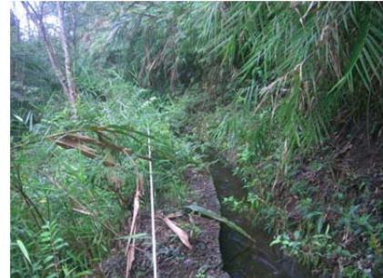
22 圳路 0k+280 混凝土內面工
