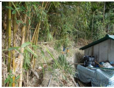
16 圳路 0k473 土渠
