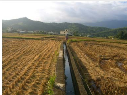
06 圳路 0k+100 混凝土內面工
