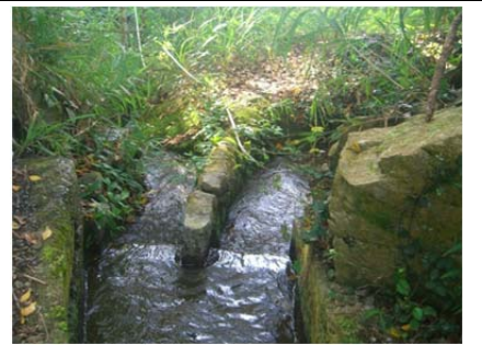
45 圳路 0k+612 混凝土分水汴
