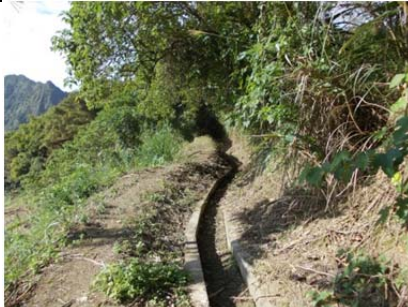
18 圳路 0k660 混凝土內面工
