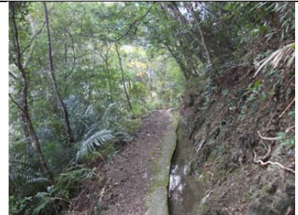
14 圳路 0k350 混凝土雙面工
