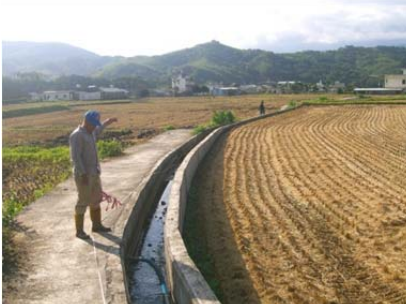
13 圳路 0k+190 凝土內面工
