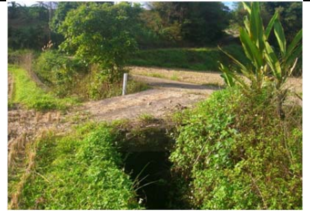
09 圳路 0k+311 混凝土農路橋
