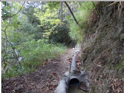
15 圳路 0k444 塑膠圳渡槽
