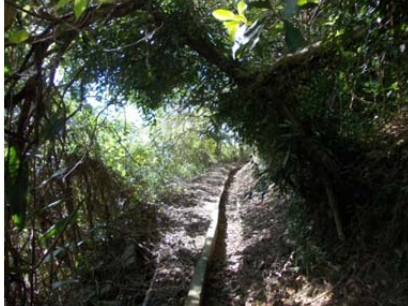
15 圳路 0k590 混凝土內面工
