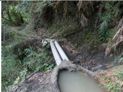
09 圳路 0k163 塑膠管渡槽
