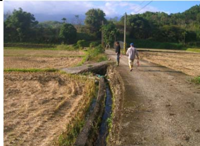
18 圳路 0k+360 混凝土內面工
