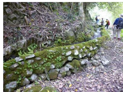
08 第一號 (Urayama) 水圳之混凝土砌塊石內面工
