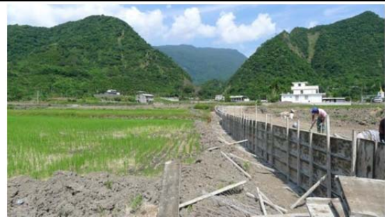
06 豐南村活動中心興建中之鋼筋混凝土內面工
