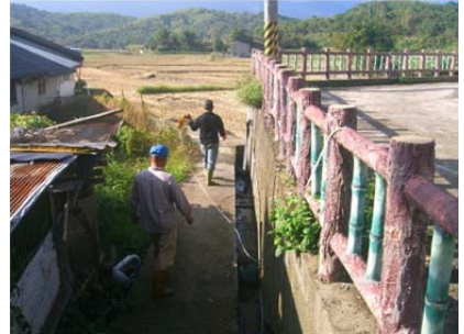
09 圳路 0k+096 凝土內面工
