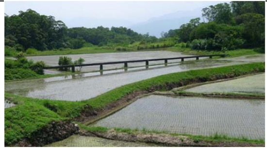
12 羅山村泥火山旁之鋼筋混凝土渡槽
