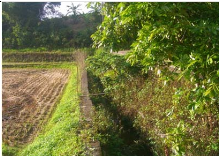
10 圳路 0k+320 混凝土砌塊石內面工
