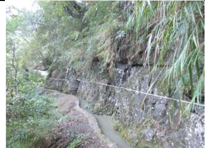
11 圳路 0k252 混凝土雙面工 及人行扶繩
