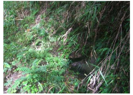
34 圳路 0k+479 混凝土暗渠
