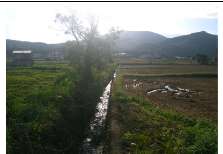
03 圳路 0k+180 混凝土砌塊石內面工
