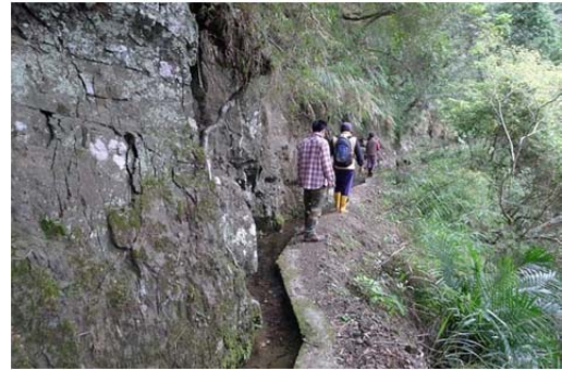
02 第一號 (Urayama) 水圳之混凝土內面工
