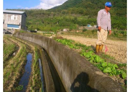
12 圳路 0k+260 混凝土內面工
