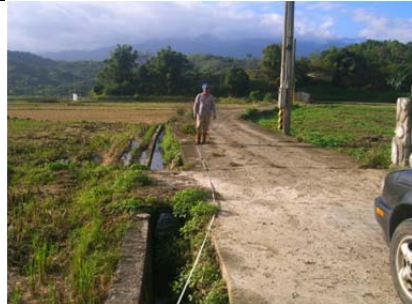
15 圳路 0k+302 混凝土農路橋
