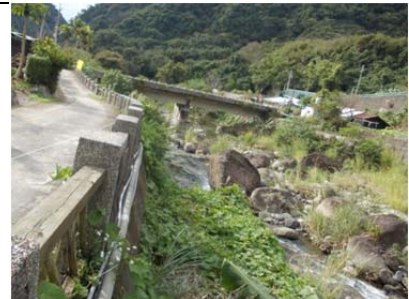
08 圳路 0k350 塑膠管管路
