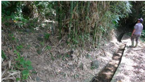
03 第二號 (Cikimay) 水圳之混凝土內面工
