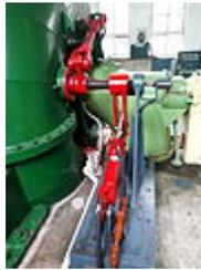
東部發電廠溪口機組水輪機動輪扇葉調整壓油設備
