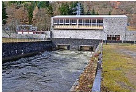
蘇格蘭佩思裝置容量僅 2MW 的小型水力發電廠
