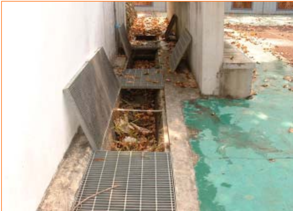
圖 3-8 於試驗點 C 點附近之操場排水溝排水不良
