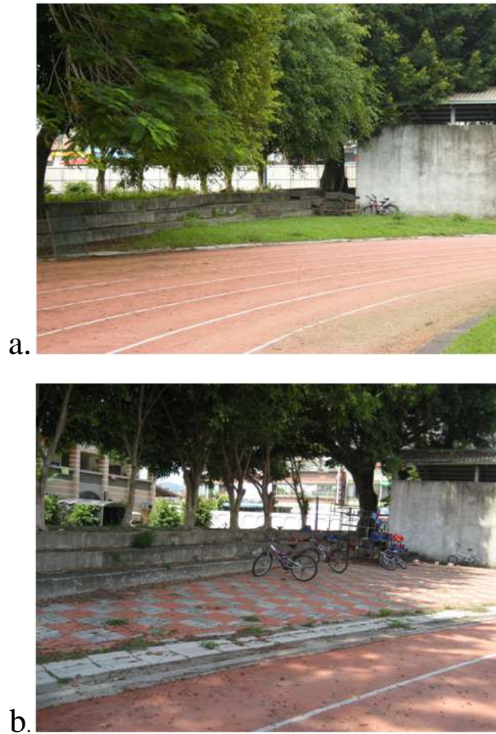
圖三、圖中顯示樣區 A 環境與設施情形，2009 年九月中旬學校施工改鋪水泥磚表面。a.施工前（2008.10-2009.9）；b.施工後（2009.9-2010.8）。
