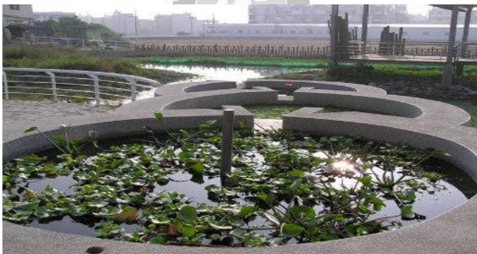
圖 4-16 水生池有高低差並加大孔洞
