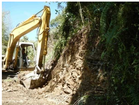
圖 19：怪手刨挖山壁一側
