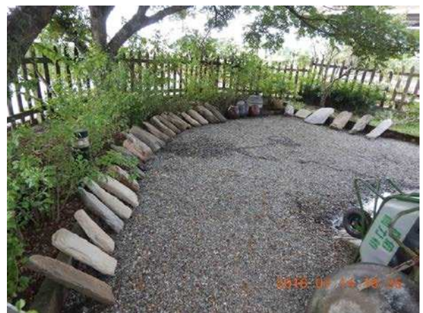
圖 29：工程出土單石排放現狀
