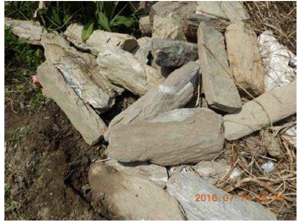
圖 25：單石多處有損傷外表
