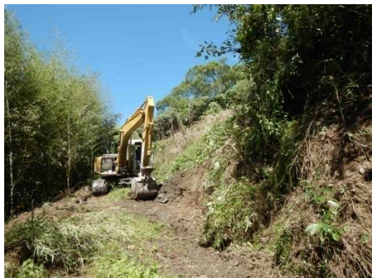
圖 18：怪手刨挖山壁一側
