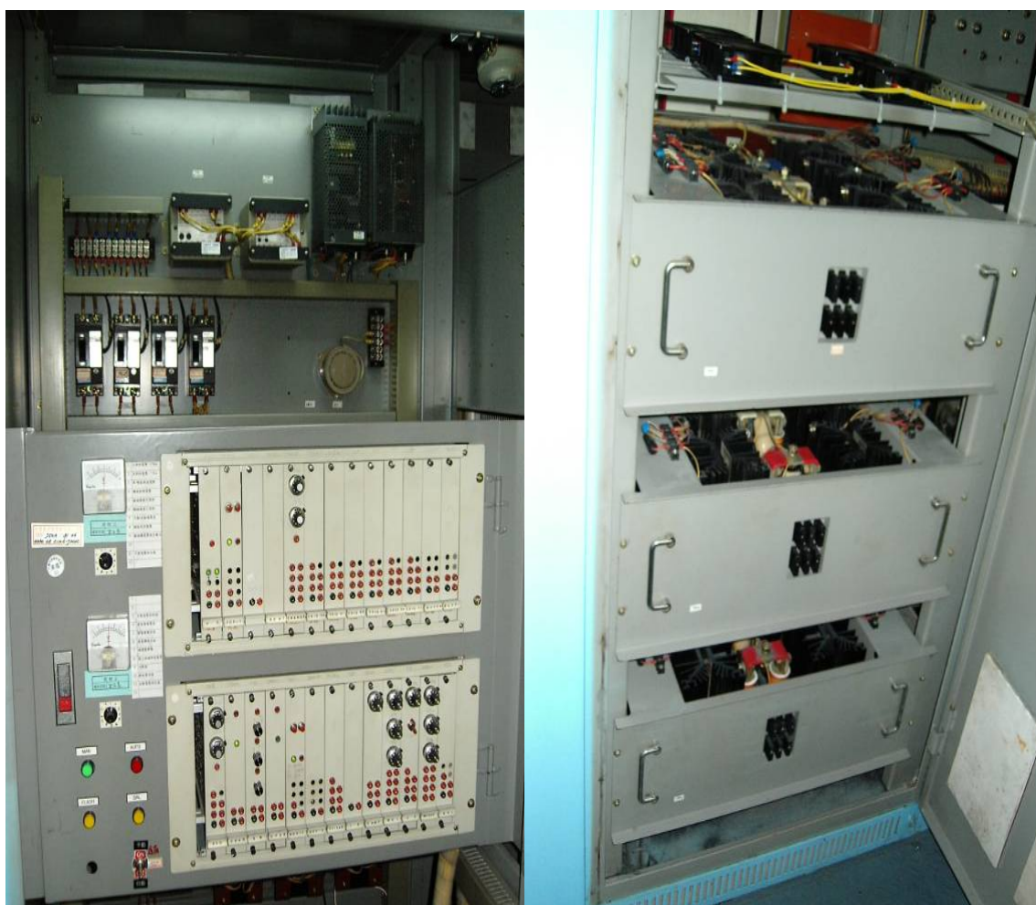
圖 3.13 勵磁機觸發控制系統部份與 SCR 輸出部份
