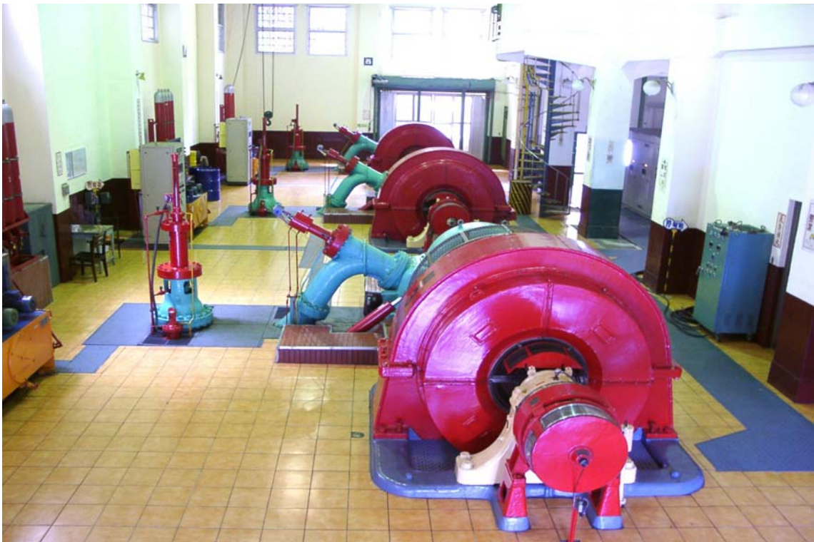
圖3.8 橫軸式發電機組
