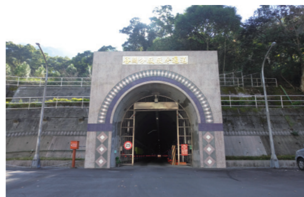
▲ 台電在復建時谷關發電廠地下廠房時，特地將通道口延伸至上谷關以防止廠房再次被洪水沖毀。
