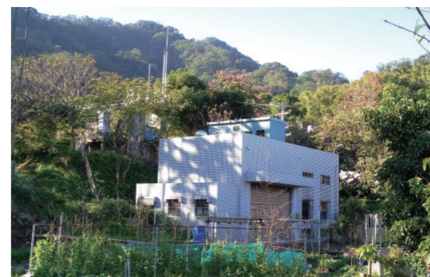
▲ 融入田野間的軟橋發電廠。面對大型水力開發的不易，成本相對低廉，能夠迅速融入環境的小水力開始受到青睞，無形之中，軟橋發電廠也成為了小水力發電的最佳典範。
