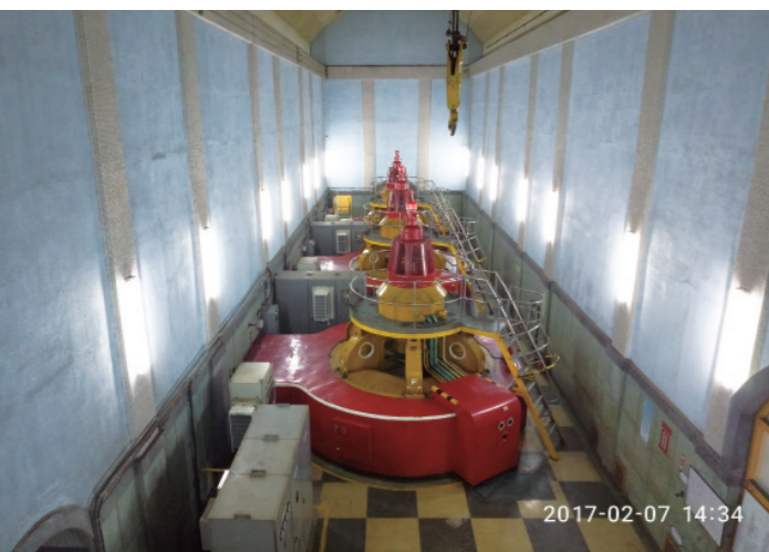
▲ 臺灣第一座地下化的銅門發電廠與三部從砂礫堆中搶救出的老發電機組。
