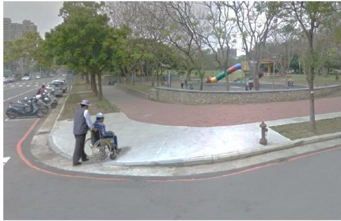
1 人行道無障礙坡道修繕
