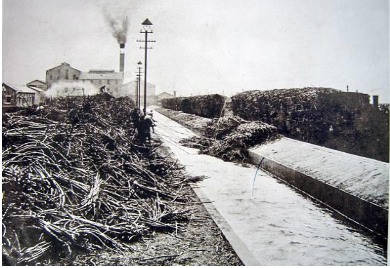
【照片 2-2-22】日治時期壽工場與冷卻水道
