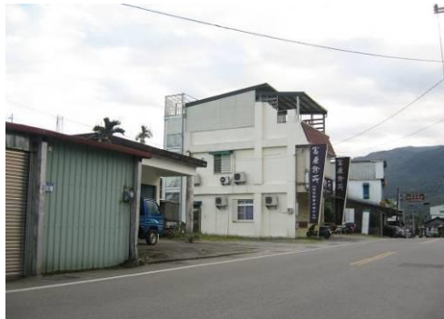
【照片 3-1-9】富源原料區設施已拆除
