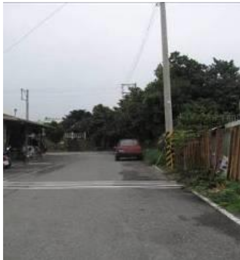
【照片 2-2- 42】光復溪北岸原有糖業鐵道路線現況 1
