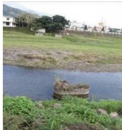
【照片 2-2-47】光復溪南岸原有糖業鐵道及橋樑建造物現況 4
