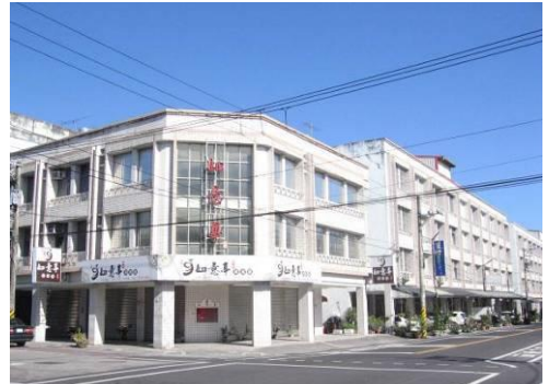
【照片 3-1-10】鳳林原料區辦公室已拆除
