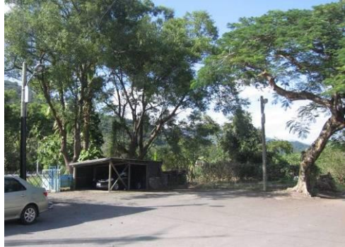
【照片 3-1-7】大禹車站原肥料倉庫已拆除
