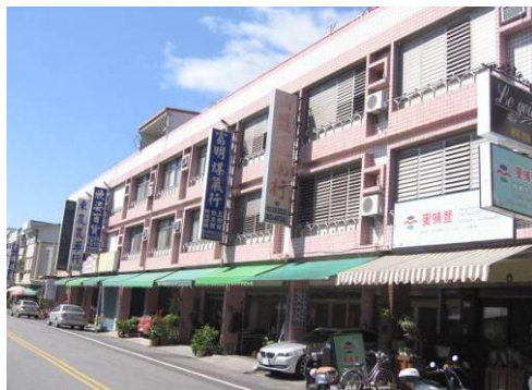
【照片 3-1-11】富里原料區設施已拆除改建
