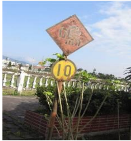
【照片 2-2-45】光復溪南岸原有糖業鐵道及橋樑建造物現況 2
