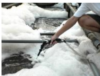
檢測曝氣池排氣臭味濃度
