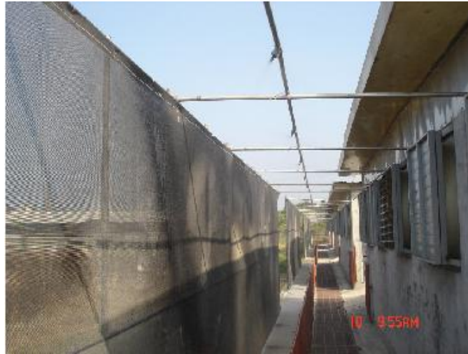
圖 1 豬舍排氣窗口除臭水霧管及防塵網(屏東縣九如鄉某養豬場)
