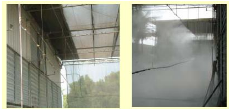
圖 2 水簾式雞舍排氣噴霧除臭及防塵網(台南縣歸仁鄉某養雞場)
