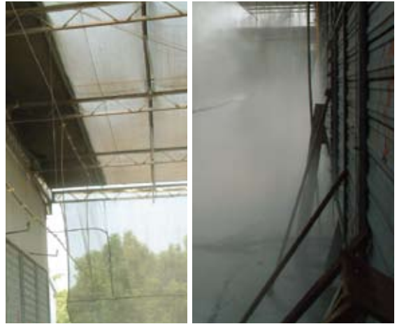
密閉水簾式雞舍防塵網外噴灑水霧或稀釋的植物精油水霧
