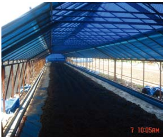
雞糞曬乾場應於雨天可遮蓋，晴天捲收遮蓋曝曬，另有邊溝收取滲出污水
