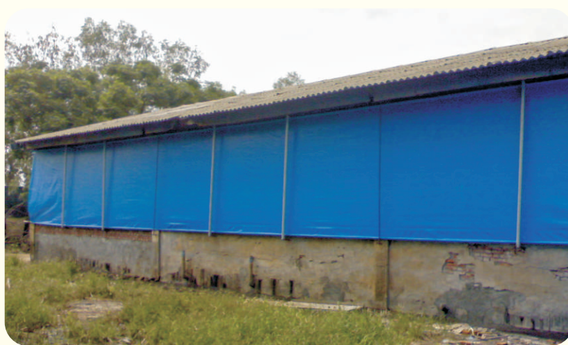
圖2-2-8. 以帆布密閉堆肥場發酵區並在內部架設集氣管線。
