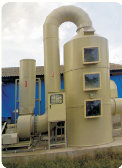
圖2-2-10 堆肥場生物滴濾法除臭裝置。
