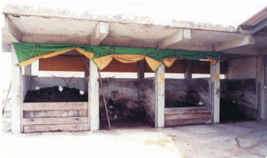
圖2-2-1. 箱型送風式堆肥發酵槽。
