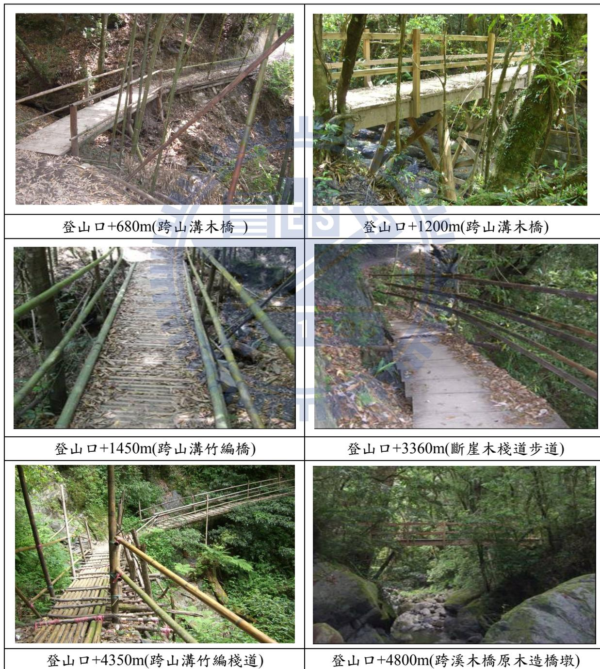
圖 5-7 司馬庫斯步道跨越結構物照片〔本研究實地拍攝〕
