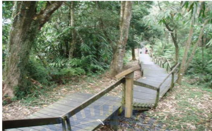
圖 2-8 回收材料製作的塑膠木面板—日月潭土亭仔步道
