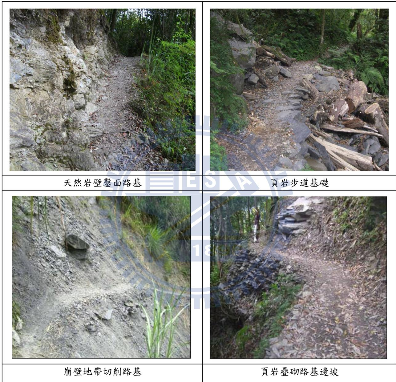
圖 5-8 司馬庫斯步道路基、邊坡防護照片〔本研究實地拍攝〕
