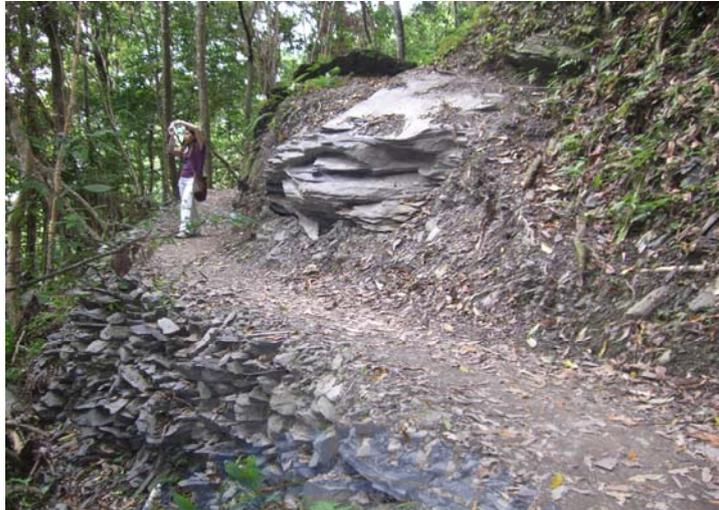
圖 2-6 司馬庫斯登山步道透水性能良好的風化頁岩石板鋪面
