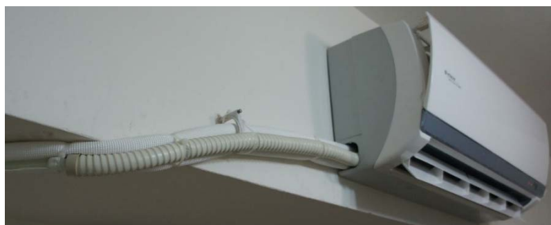
圖 2.6 分離式冷氣冷凝水管(Akram 等人, 2018)
