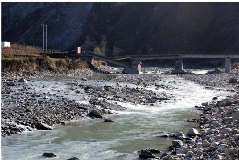
圖15 在谷口前，自唐代起就有渡河的需求，現在尚有橋樑。此橋在2010年被水沖毀，尚未修復。拍攝點34°5'56.20"N, 109°19'32.23"E, 角度約165°
