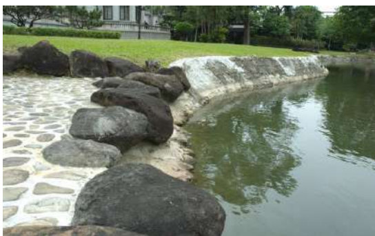
圖 4-5 台北賓館漿砌卵石護岸
