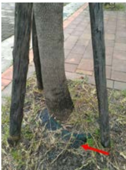
▲ 根部生長受限 (樹袋未拆)。
