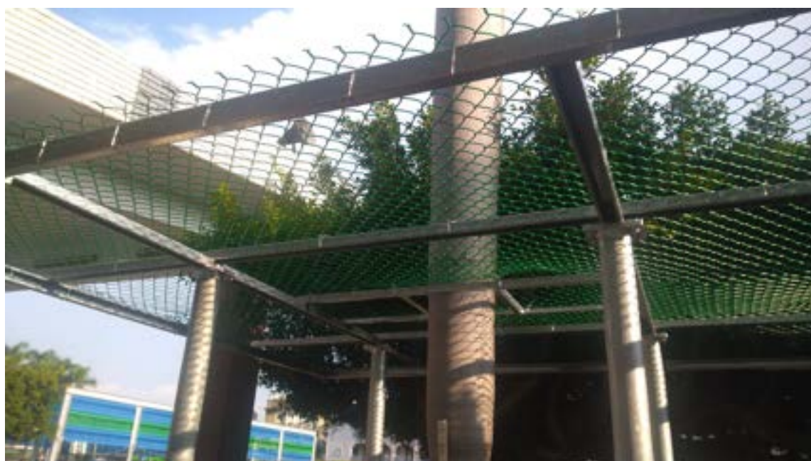
▲ 圖 36. 可於樹下設置防護網。
