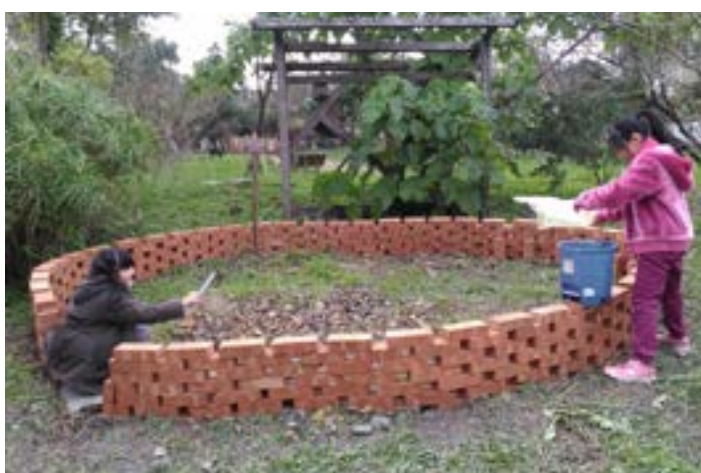
▲ 有堆置區落葉堆肥堆置情形。
