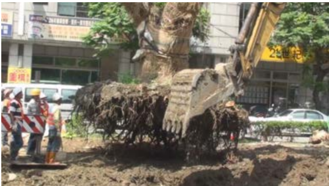
喬木吊運過程中無包裹，根球破裂
