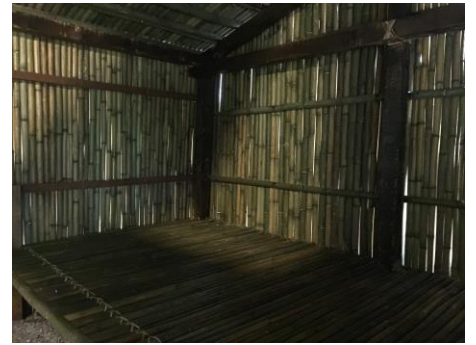
說明：室內陳設施作(青少年床鋪，以竹壓扁成蓆狀鋪排，並以藤皮繫結。)
