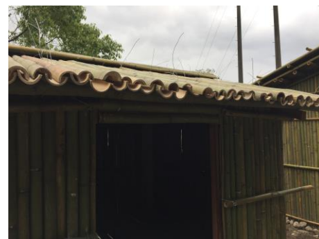
說明：屋頂鋪設，傳統施作方式是將竹剖半再合抱編排。
