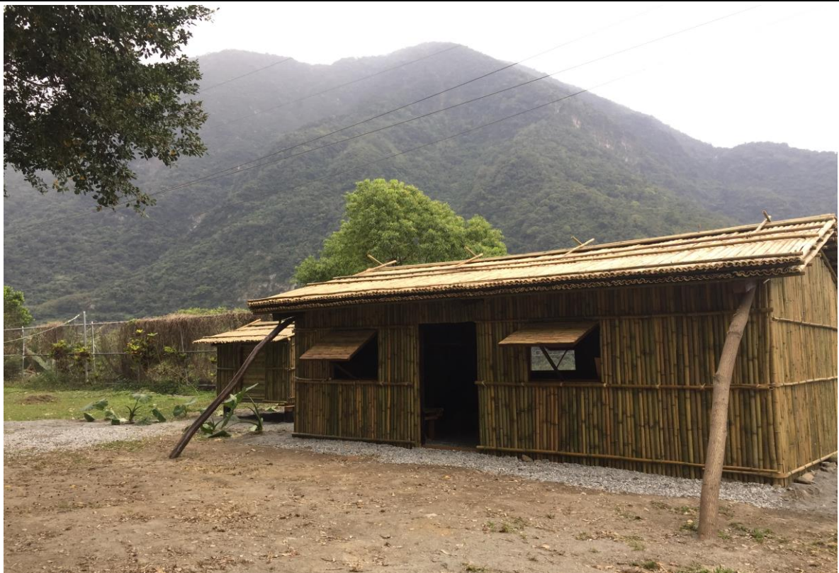
說明：立斜撐，家屋外牆週遭以杉木斜撐補強其結構性。(住屋 穀倉完成)
