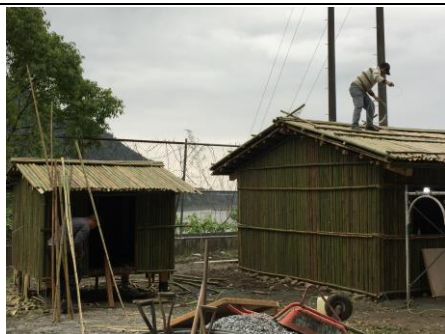
說明：上壓條以固定屋頂面。 (防漏水)
