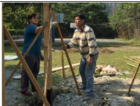
說明：工班進行穀倉立主屋結構柱。
