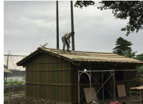
說明：屋脊接縫處做防雨水、防漏處理。
