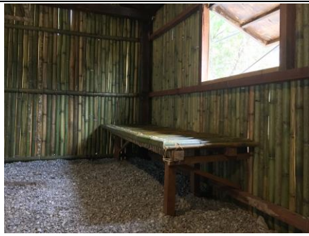
說明：室內陳設施作(父母親床鋪，以竹壓扁成蓆狀鋪排，並以藤皮繫結。)
