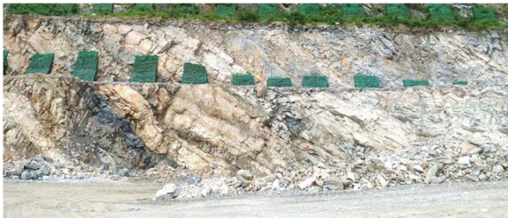
圖 3. 礦區採掘後，岩層裸露土地嚴重退化，植物無法生存。
