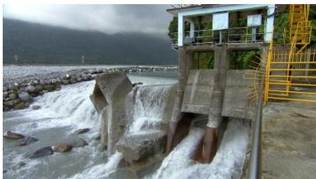
水力發電的原理是利用水位的落差（勢能）在重力作用下流動（動能）衝擊帶動發電機的水輪機，再將動能轉換成電能。水力發電的種類則有水庫式、川流式、調整池式、潮汐發電、抽水蓄能式，而溪口電廠則屬於川流式發電。水力發電的優點不外乎式乎不會產生汙染，發電成本相對於其他發電方式來說是低廉的，且水力發電還能提供發電以外的用處，像是溪口電廠的尾水能提供灌溉用途。
