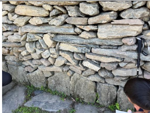
圖 5 石板屋最下方的石頭特別厚，主要是預防下雨的時候，雨水濺進家屋，還有防蛇進入的效果
