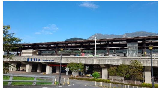
圖 4 壽豐車站重建後實景
