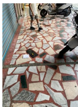
圖 26、隔壁店家騎樓 的地板也有蛇紋岩石 板
