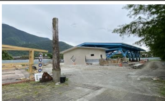
興建中的新址(圖源:作者提供)
