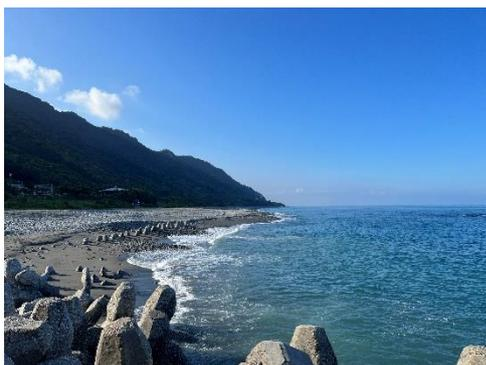
圖 3：北邊明顯出現沙灘堆積的狀況，消波塊都被埋在沙灘中。
