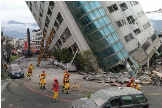
圖 6 雲門翠堤大樓緊急支撐作業
