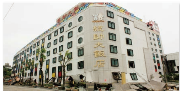
圖2 統帥飯店大樓倒塌現場
