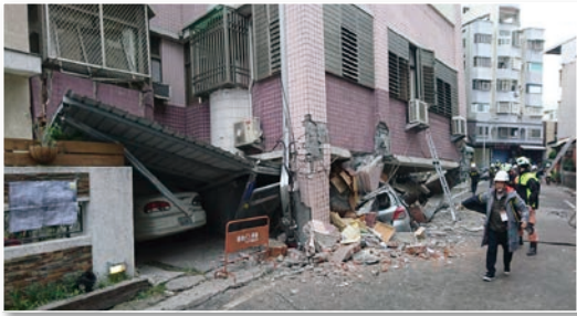
圖 3 吾居吾宿大樓倒塌現場
