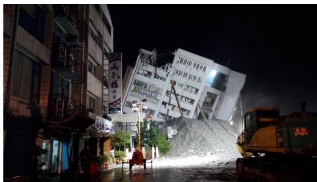
(圖十六) 填土堆高防止倒塌
