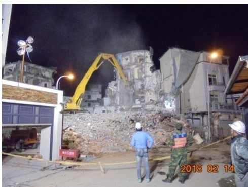
(圖十七) 拆除中的白金雙星大樓
