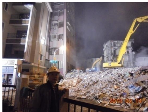
(圖十八) 利用拆下的土石支撐吾居吾宿大樓
