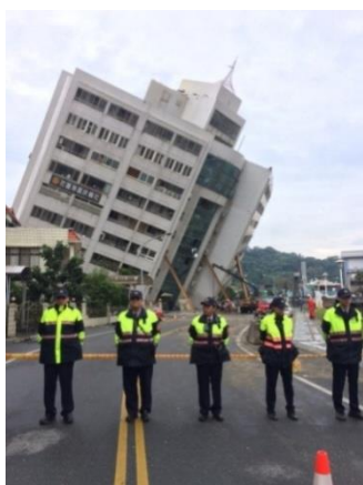
(圖七) 傾倒的雲翠大樓
