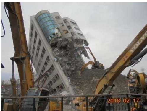
(圖十五) 由背面開挖保障工作人員安全
