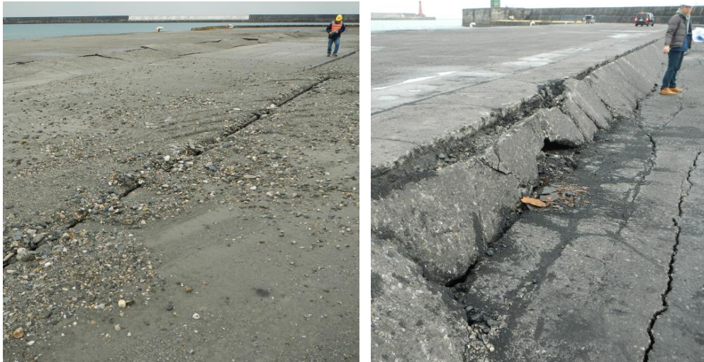
照片 7 花蓮港#24 碼頭後線礫石噴出地表；#25 碼頭後線沉陷情形(柯永彥攝)
