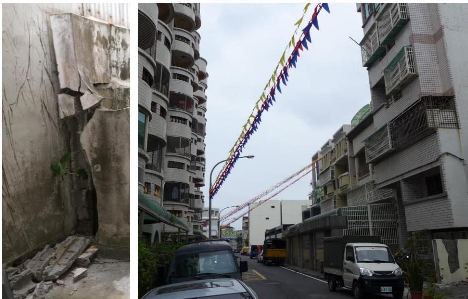
照片 6 國盛五街富臨門大樓及佳美華廈，皆發生液化震陷及傾斜，但前者梁柱受剪而開裂破壞
