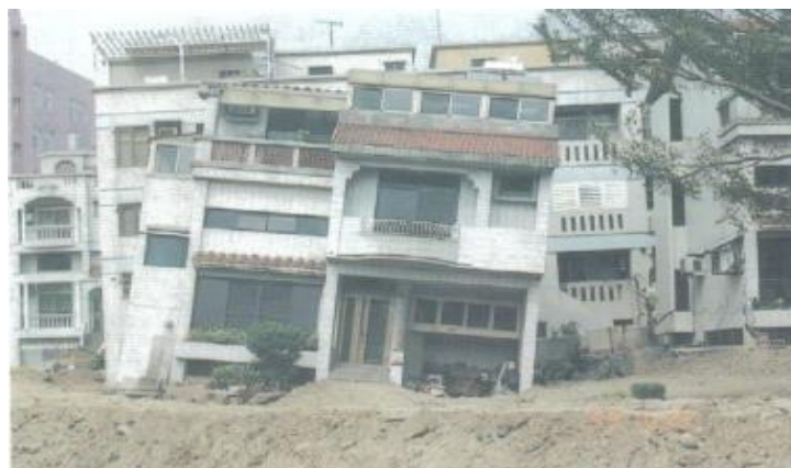
圖三 霧峰民房液化下陷傾斜
