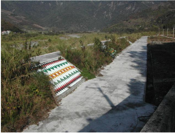
(1) 廣原堤防坡面植生及景觀工程(93.05) (2)福文堤防砌石坡面植生茂密(93.08)
