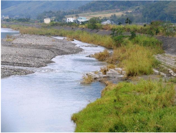
(11)長良堤防混凝土型塊丁壩營造多樣化(12) 玉里堤防丁壩營造棲地(93.08) 棲地(93.12)
