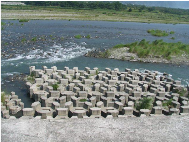
(18) 瑞美村堤防丁壩尚未掛淤，但已營造 深流(93.08)
