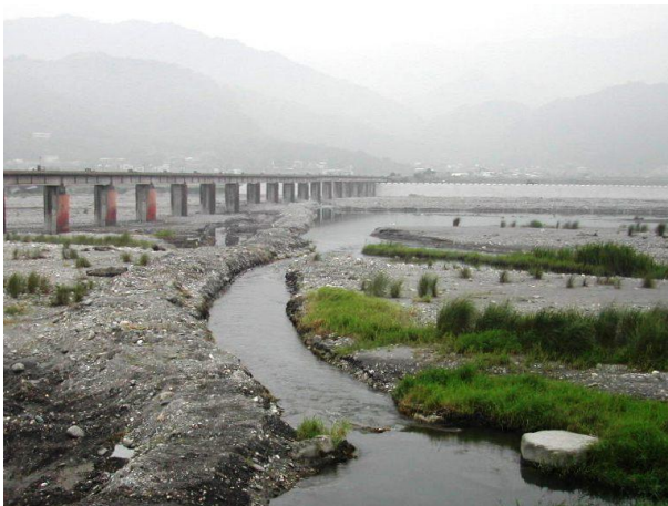
(9) 太平渠臨時導水堤(93.05)
