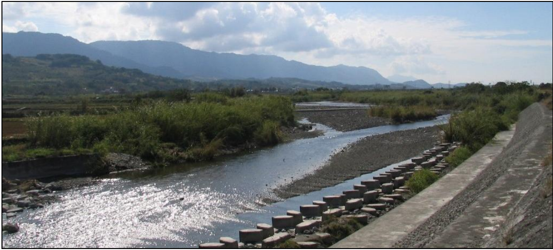
(1) 主流中游，縣界圳攔河堰上游，河川環境會受人為（開挖導水路）影響。
