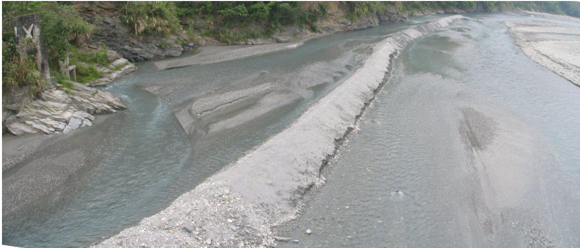
(1) 大禹圳取水口緊鄰主流而設，僅配置小型導水工。(94.05)
