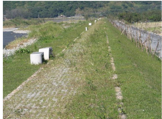
(3) 萬朝堤內連結混凝土版允許植生附著 (93.08) (4)富南堤覆土及遊憩設施形成綠堤 (93.12)
