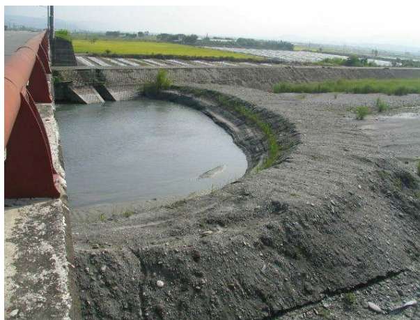
(3) 迪佳圳取水口位居下游截斷流路(94.05)
