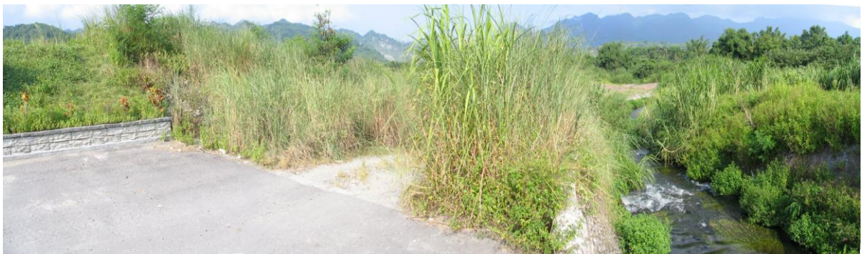
(5) 瑞美堤防下游排水出口及濕地
