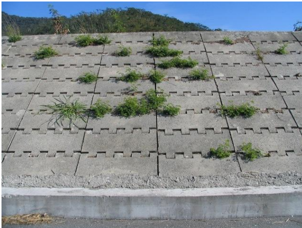
(3) 萬朝堤內連結混凝土版允許植生附著 (93.08) (4)富南堤覆土及遊憩設施形成綠堤 (93.12)
