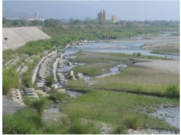
(11)長良堤防混凝土型塊丁壩營造多樣化(12) 玉里堤防丁壩營造棲地(93.08) 棲地(93.12)
