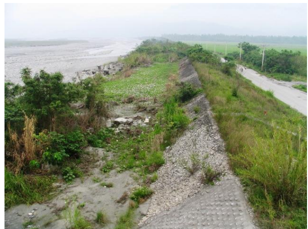
(3) 長良堤防堤外混凝土型塊挑流丁壩營造多樣性棲地及堤內覆土有機會串連成生態廊道(94.08)
