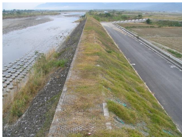
(9) 新莊堤防堤內掛網植生(93.08)
