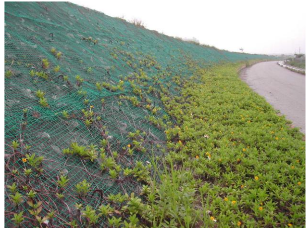
(7) 東里堤防外有丁壩生成深潭。(93.12) (8) 東里堤防堤內掛網植生細景(93.12)
