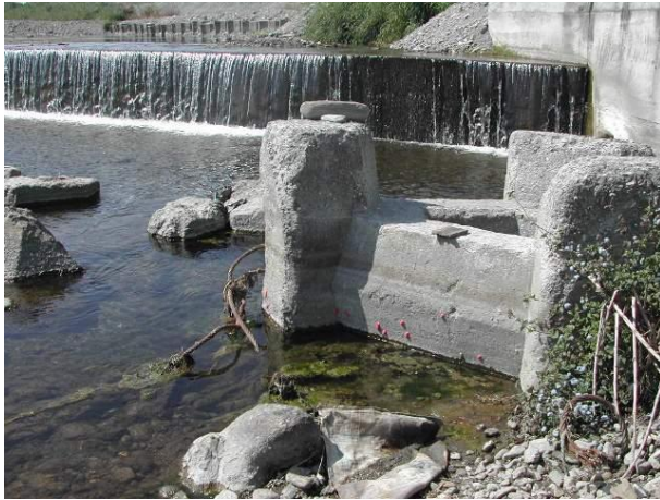
(3) 縣界圳攔河堰水位差約 1 公尺(93.05) (4)縣界圳七支線攔河堰(93.12)
