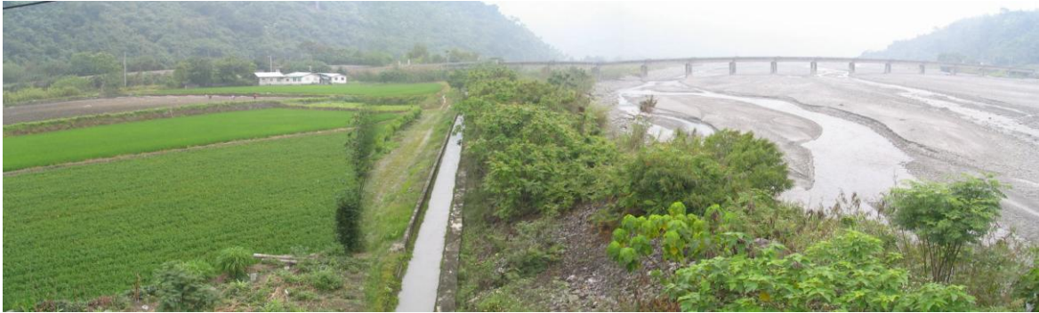
(4) 大禹堤防堤外有自然植生覆蓋，有機會與堤內形成綠色廊道(94.08)
