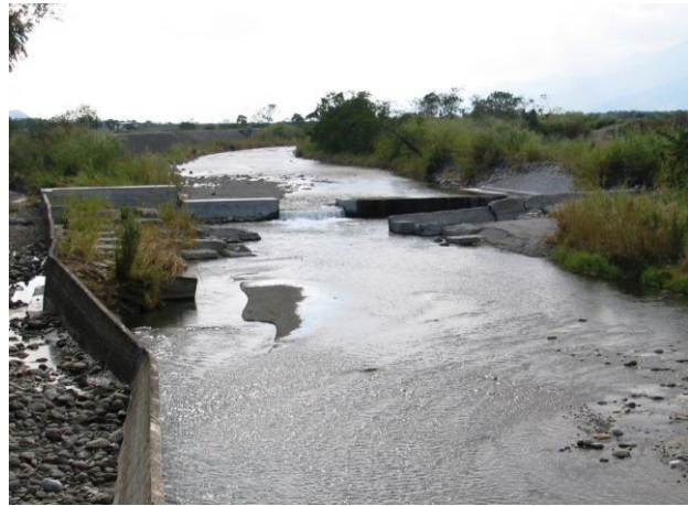
(3) 縣界圳攔河堰水位差約 1 公尺(93.05) (4)縣界圳七支線攔河堰(93.12)
