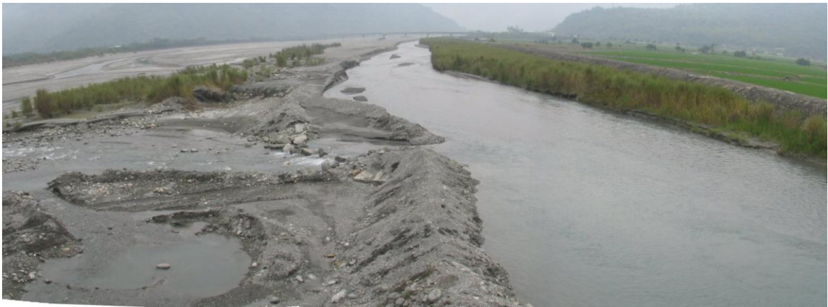
(5) 三民一號堤外有導水路工程，在堤腳形成穩定之水際綠帶。(94.08)
