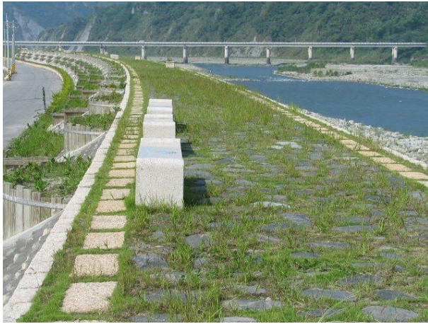
(16)瑞美村堤防坡面植生及景觀工程(93.05)
