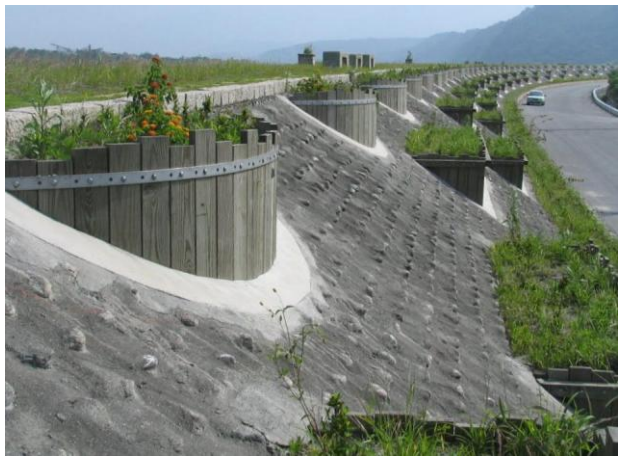
(17) 瑞美村堤防坡面植生及景觀工程(93.05)
