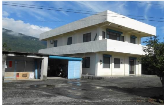
說明：較新建的二層樓鋼筋混凝土住家
