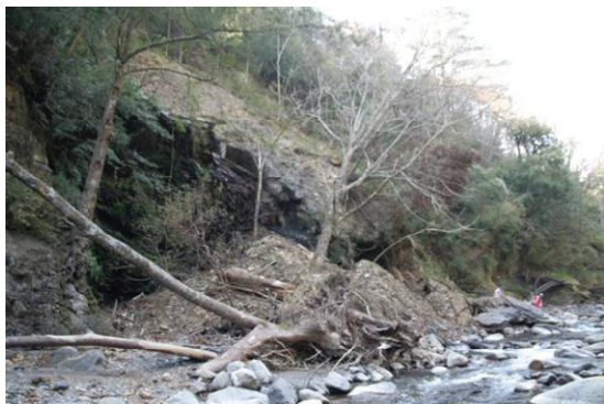
圖 4 河岸崩塌導致土砂及林木進入河道
