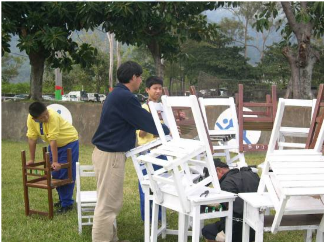
(7) 底座一定要固定好，才利於推疊。(圖 4-3-22) 聖誕樹施工 3
