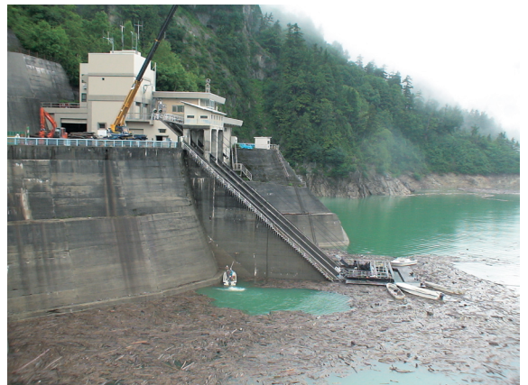
▲照片10 黑部水庫漂流木打撈情形。
