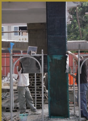
碳纖維補強： 以碳纖維布包覆柱子。
