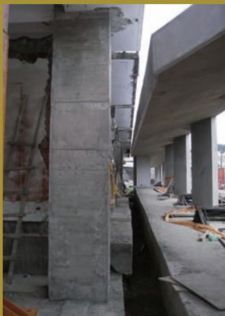
擴柱補強： 增加鋼筋並把柱子加粗。
