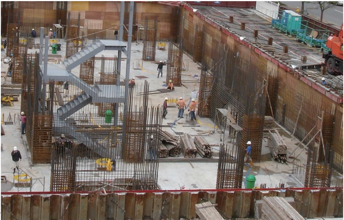
正在進行鋼筋混凝土結構的鋼筋組立工程
