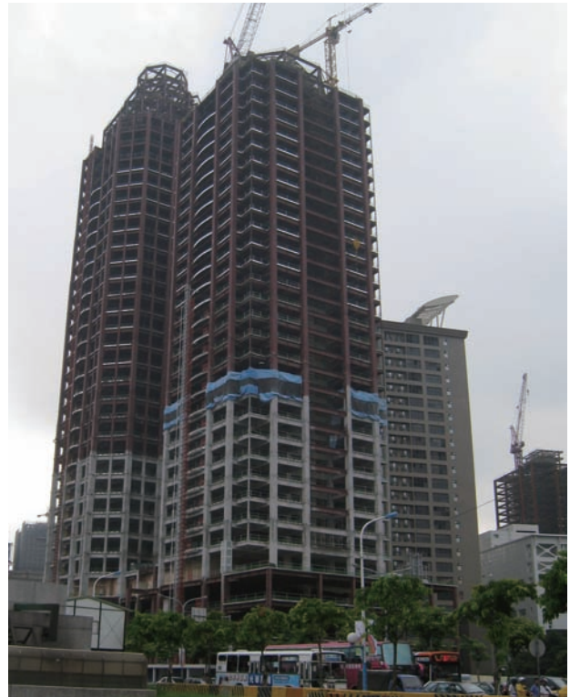
施工中的鋼結構建築，白色部分是防火被覆工程。
