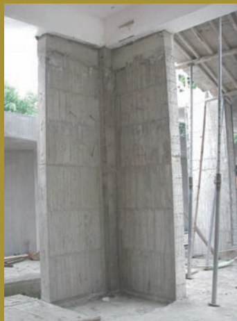
翼牆補強： 在柱子側面增建翼牆。
