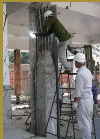
鋼板補強： 以鋼板包覆柱子。
