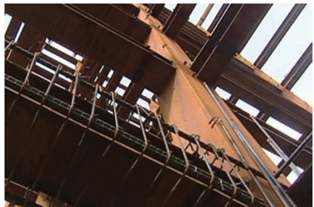
鋼骨外圍網綁鋼筋的SRC結構
