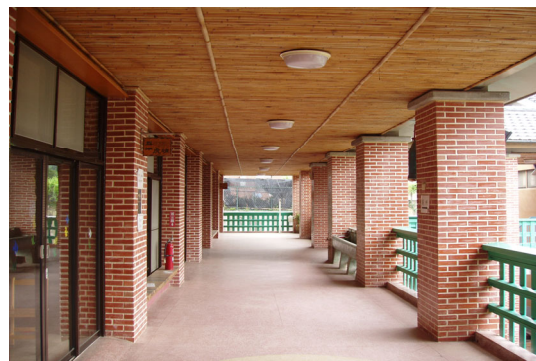
竹製走廊天花板
