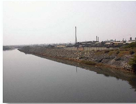
位於三爺宮溪畔的廠房
