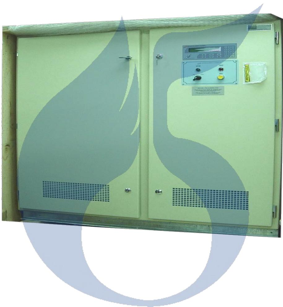
圖 5-4 15kVA 直流交流電轉換器
