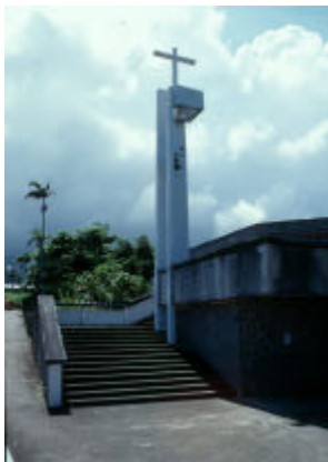
【圖 3.3-41】長濱堂區 長光天主堂鐘塔細部
