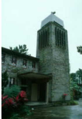
【圖 3.1-75】新城堂區 聖母元后堂入口空間
