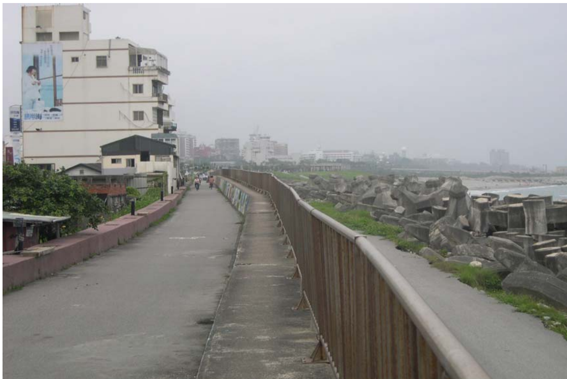
圖 3.6.1.26 花蓮市北濱海堤(照片中不銹鋼欄杆旁之高程約 8.6 公尺)
