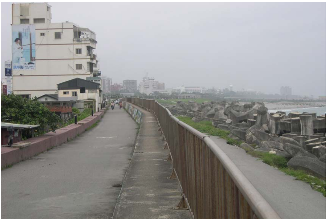
圖 3.6.1.24 花蓮市北濱海堤(照片中不銹鋼欄杆旁之高程約 7.6 公尺)
