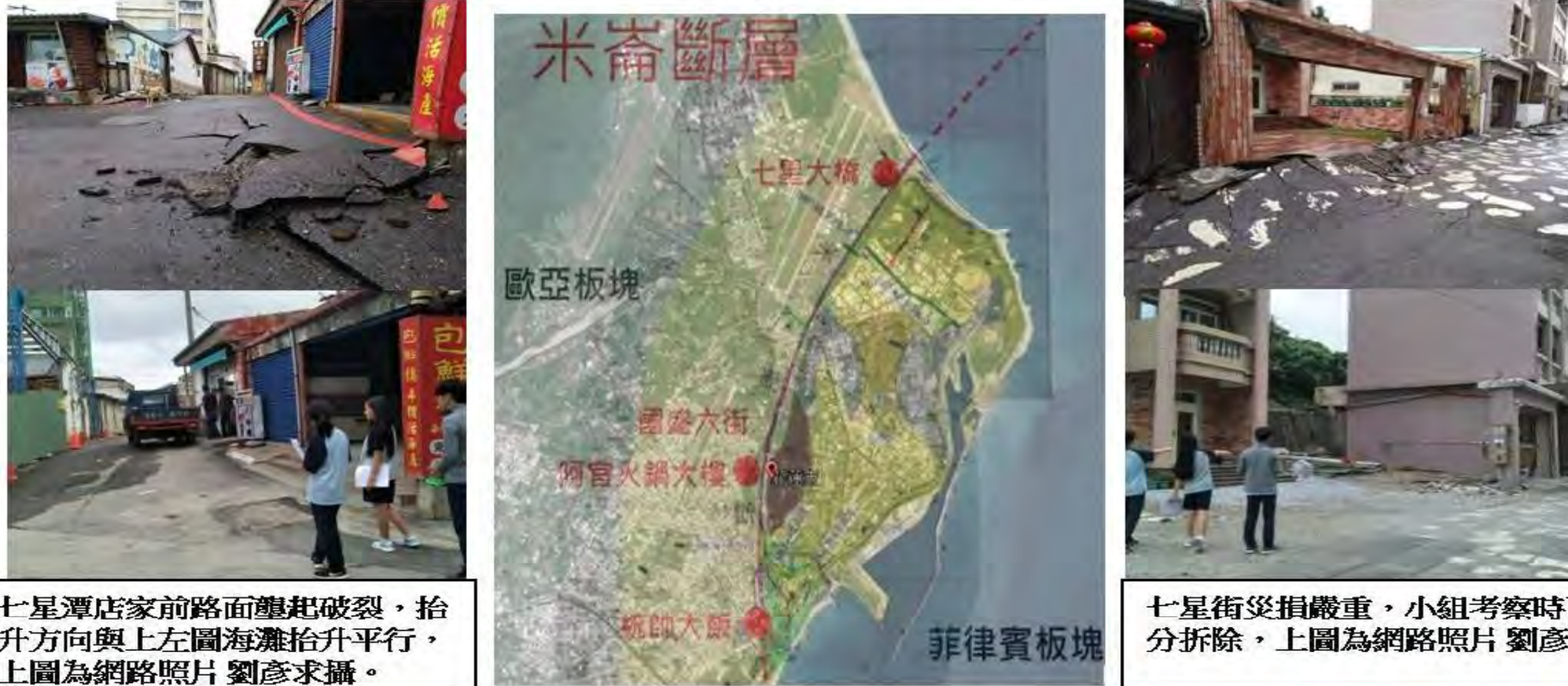
上圖左為七星潭南側海灘出現約50°西走向的地表破裂面，防坡堤因錯動而出現裂縫，左側對應美崙斷層上盤，應起約近30公分，平行海岸出現一段北36°西低角度傾斜破裂線，西側應起約25公分。兩者接近垂直
