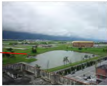
照片 1-5 美崙空軍營區內之崖下斷層 池為當年花蓮大地震地表錯動痕跡
