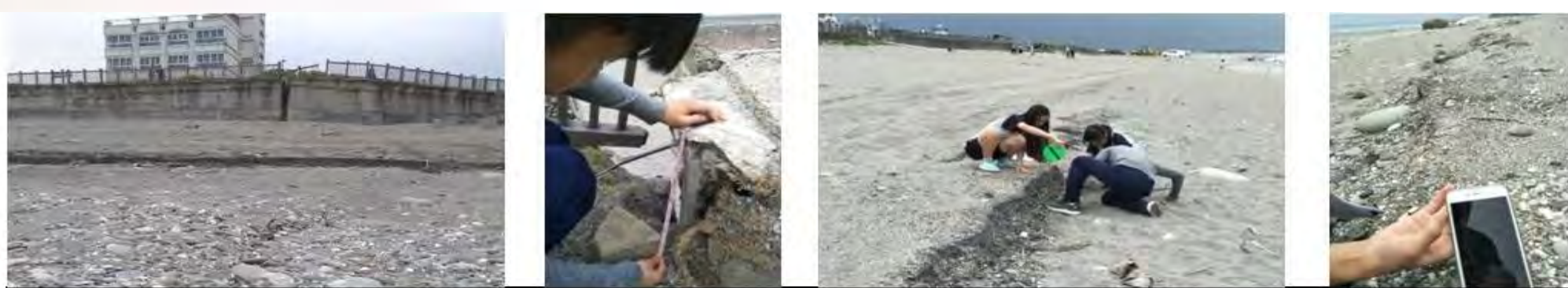
上圖左為七星潭南側海灘出現約50°西走向的地表破裂面，防坡堤因錯動而出現裂縫，左側對應美崙斷層上盤，應起約近30公分，平行海岸出現一段北36°西低角度傾斜破裂線，西側應起約25公分。兩者接近垂直
