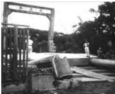
照片 1-6 當年大地震後破裂面經過 忠烈祠牌樓造成柱斷梯毀景像
