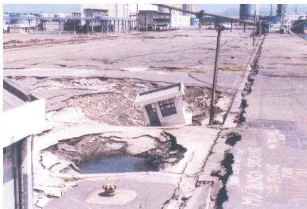
圖三 台中港三號碼頭後線回填區嚴重下陷 (簡連貴攝, 摘自九二一集集大地震大地工程震災調查報告)。
