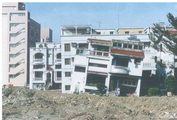
圖四 台中霧峰鄉太子城堡因土壤液化而導致房屋傾斜(褚炳麟攝, 摘自九二一集集大地震大地工程震災調查報告)。
